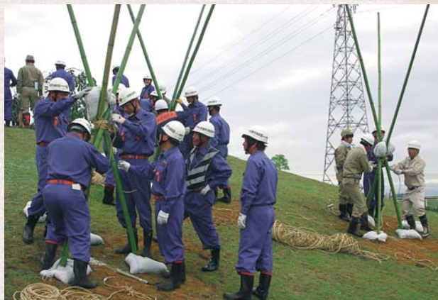
川裏亀裂、崩壊の拡大防止に有効な「五徳縫い工法」
