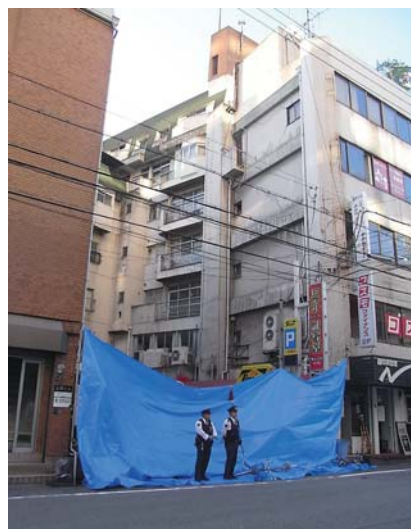
大阪市浪速区個室ビデオ店の火災後の状況
